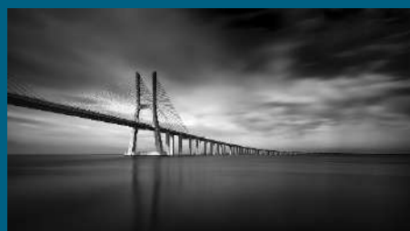
VADCA DA GAMA BRIDGE
